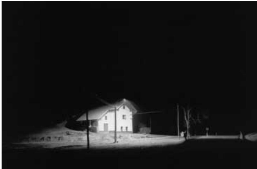
*Slika 8: Nočni posnetek zasenčene svetilke ST-50 po sanaciji (marec 2001) iz razdalje 120 m. Z uporabo svetilke z ravnim steklom je popolnoma odpravljeno bleščanje in uhajanje svetlobe proti nebu. Osvetlitev je trajala 15 sekund. Za primerjavo stanja pred in po sanaciji glej še sliko 4.*
